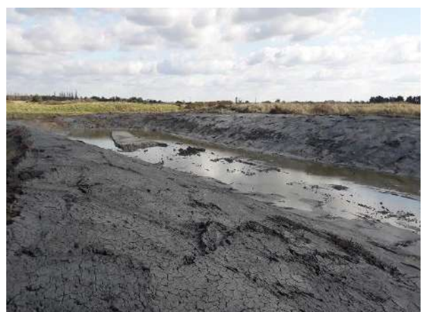
Pendant les travaux, Octobre 2020
