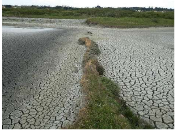
Diguette séparant les bassins 10 et 11, 2021
