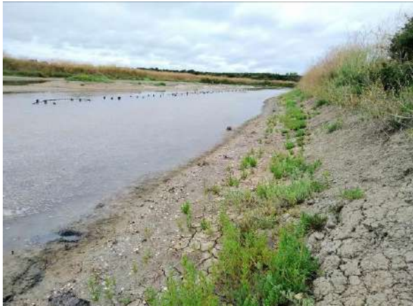
Vue des berges reprofilées et des îlots créés, 2020
