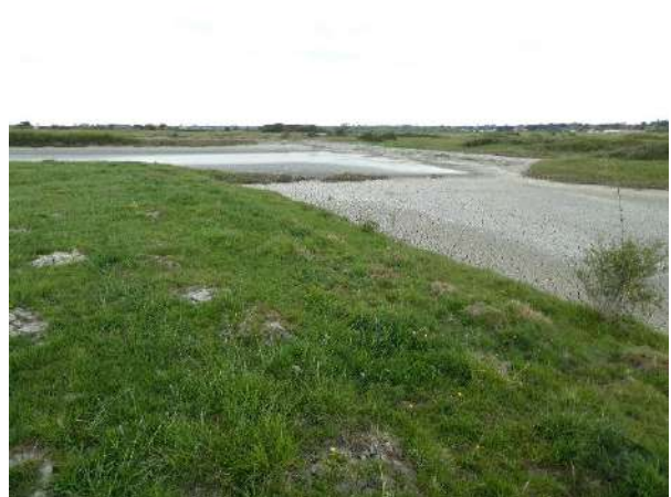
Vue des bassins 10 et 11 et de la digue restaurée
