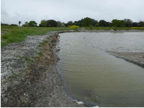
Détail d'une berge suite aux travaux, 2021
