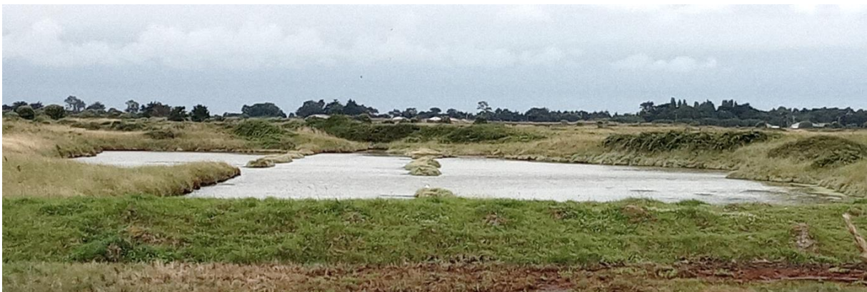
Figure 15 : bassin du Fondreau Nord en juillet (S.NOËL)
