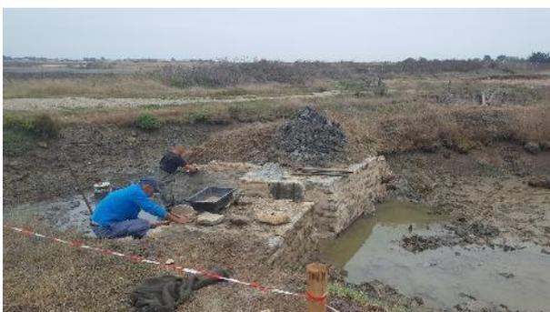
*Restauration manuelle d'un éraille (ouvrage hydraulique traditionnel sur l'île de Noirmoutier) (CCIN)*
